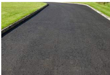
3.5.1. pav. Asfalto danga
