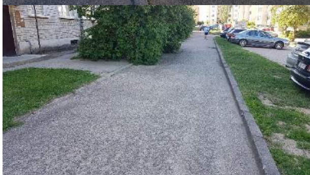
2.5.3.2 pav. Dangos esamos kiemuose. Ištrupėjęs, duobėtas asfaltas. Išvažinėta veja ir žvyro danga
