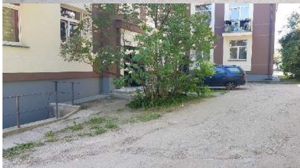
2.5.2.19 pav. Pakalnės g. 23 yra įrengta naujai nuogrinda, tako nėra jungiančio su gatvėmis ir kitais pastatais
