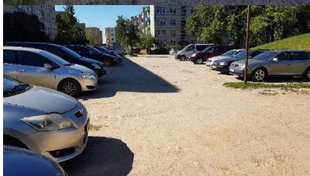
2.5.3.2 pav. Dangos esamos kiemuose. Ištrupėjęs, duobėtas asfaltas. Išvažinėta veja ir žvyro danga
