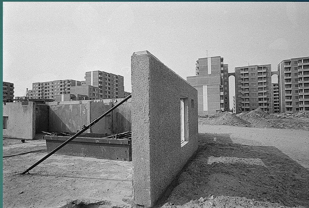
Pav. Stambiaplokščio namo statyba
