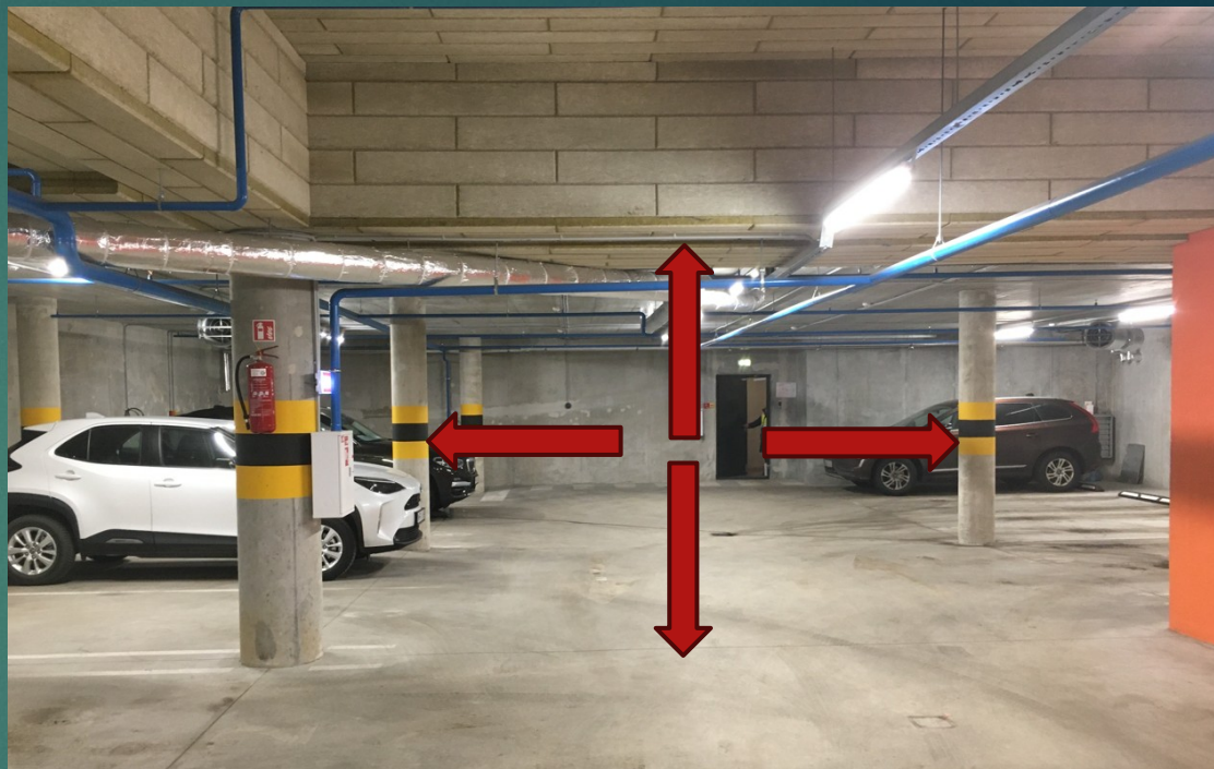
Pav. PSP sieną galima tvirtinti į esančias kolonas, grindų plokštę ir denginio plokštę
