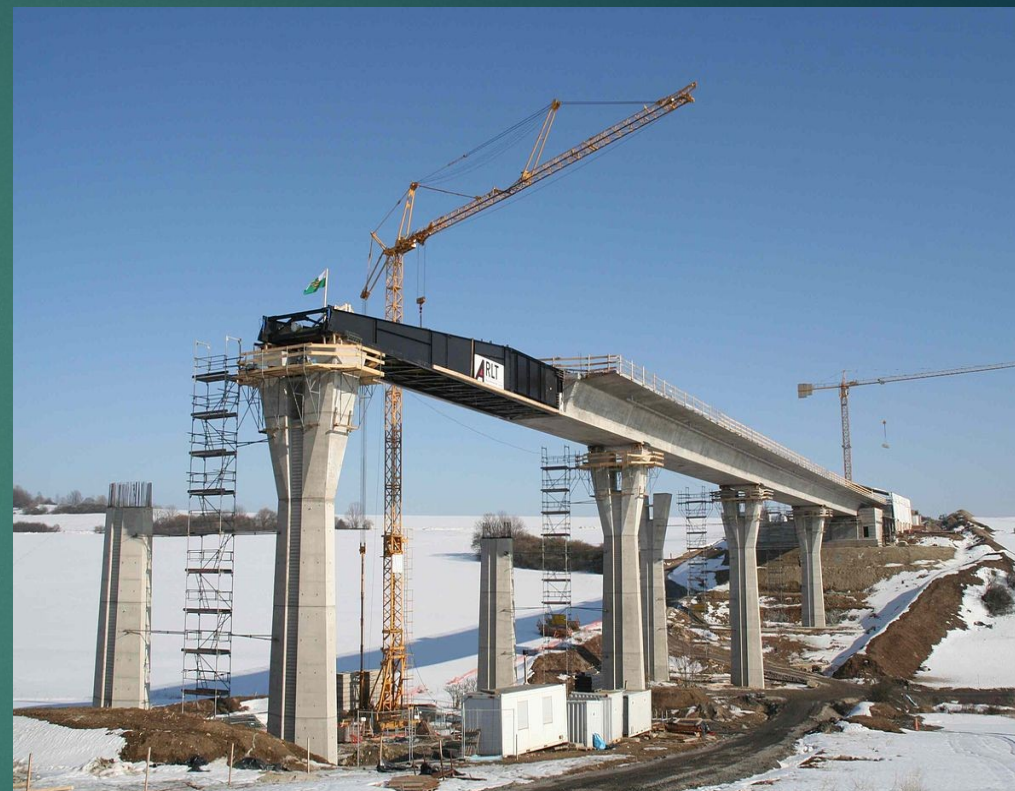
Pav. Inžinerinis statinys - estakada
