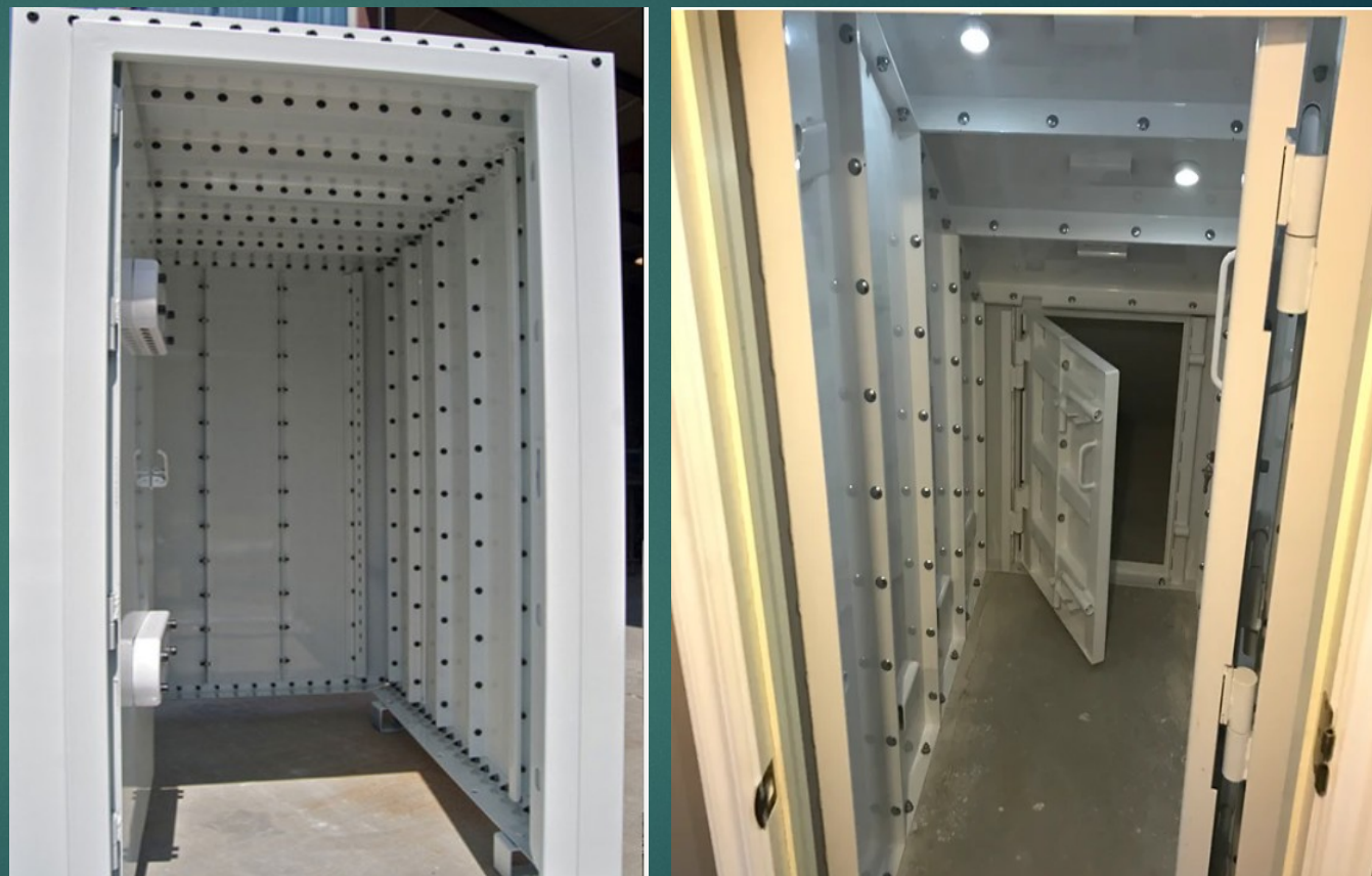
Pav. Pertvarų stiprinimui naudojami plieniniai skydai
