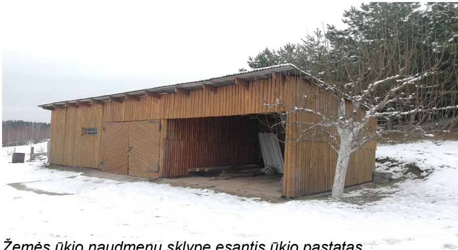
Žemės ūkio naudmenų sklype esantis ūkio pastatas
