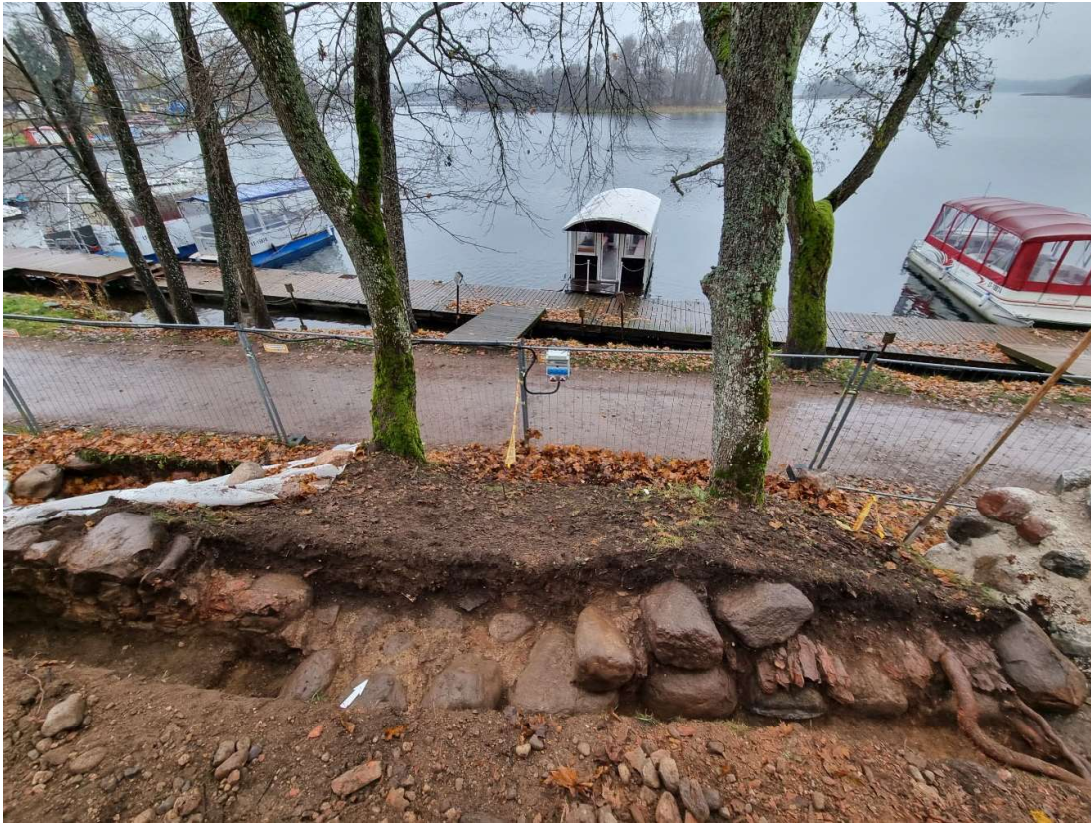
1 Pav. Atidengtos sienos pamatai, vaizdas iš pietryčių pusės.
